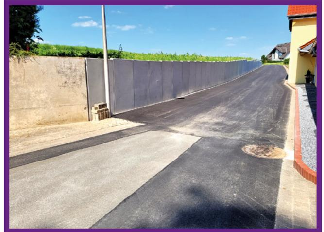
Aus Verkehrssicherungsgründen wurde die Bruchsteinmauer „In den Blessen“ in Barkhausen abgetragen und es wurden L-Steine eingebaut. Zudem ist die Straße saniert und verbreitert worden.
