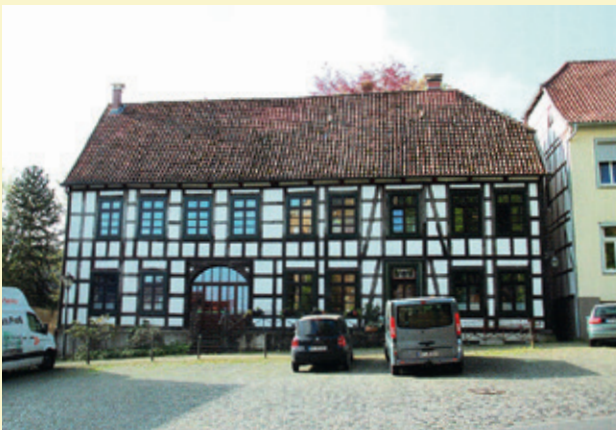
Heutige Ansicht des Hauses (Foto: B. Meyer)
