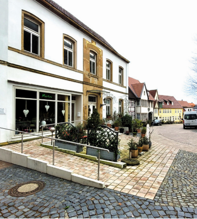
An dem barrierefreien Zugang zur Martini-Begegnungsstätte in der Kirchhofsburg wurde ein Handlauf angebracht.
