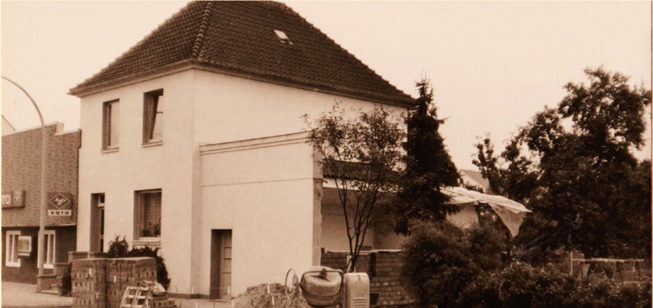
Umbau des Ateliers
